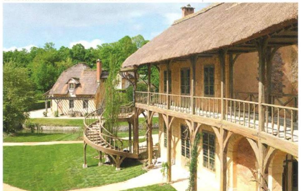
La maison de la Reine rénovée. © Château de Versailles
